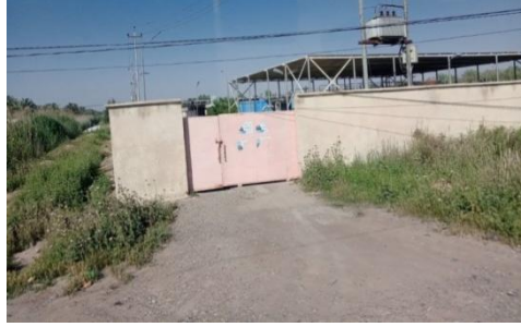
صورة (١) مشروع منطقة شاقراق للمياه الصالحة للشرب
