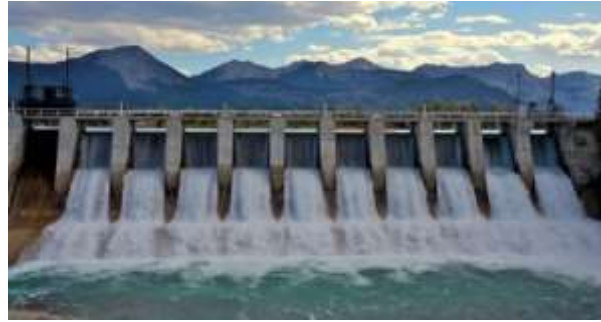
شكل 2 احد سدود توليد الطاقة الكهربائية
