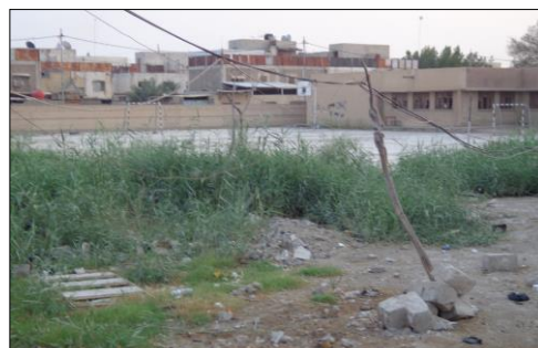
شكل (٨). التلوث الذي نتج عن إرتفاع مناسيب مياه الصرف الصحي فوق مستوى سطح الأرض في مدينة الزبير
