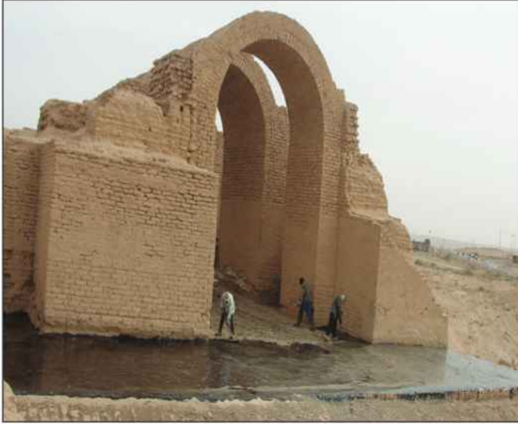
صورة رقم (3) بوابة تاييرا / بناء من اللبن مغلف بالاجر والارضية من الاجر القرشي والمونة الرابطة من القير وهيكل البوابة بشكل عام مبني من اللبن المجفف بالشمس مغلف بالاجر المشوي
