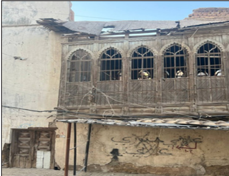
شكل رقم (28) صورة توضح الاسلاك الكهربائية المتعلقة بالشناشيل (تصوير الباحث 2023).
