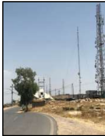
الصورة رقم (٩) الصورة توضح الابراج واجهزة الاتصالات في منطقة الدراسة
