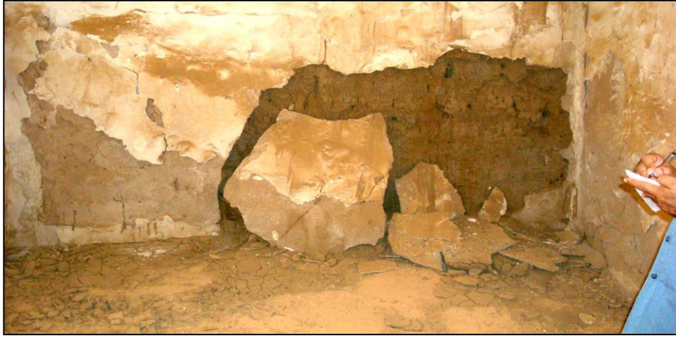
صورة (٢) أثر عمليات التمدد الناتج عن النمو البلوري
