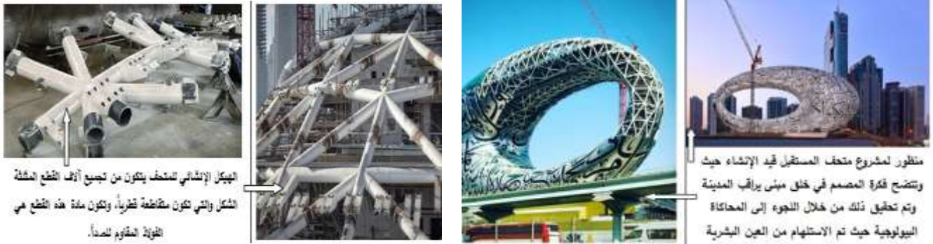
شكل (7): يوضح المنظور الخارجي لمتحف المستقبل وهو قيد الإنشاء وتفاصيل القطع الفولاذية المثبتة المستخدمة في تشكيل الهيكل الإنشائي للمتحف وطريقة الرابط القطري بين القطع. المصدر: (Writer, 2019).
