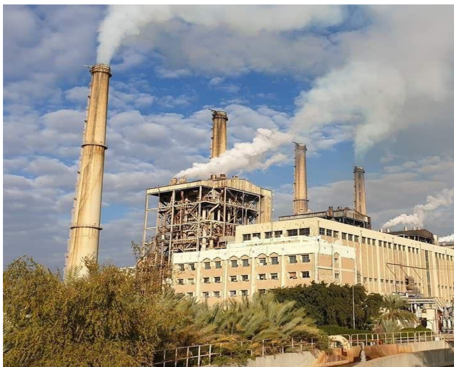
صورة (١) محطة المسيب الحرارية في محافظة بابل
