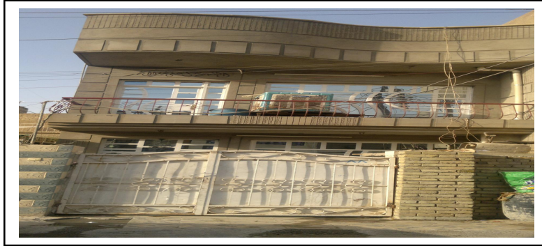
صورة (1): وحدة سكنية مشيدة بمساحات غير مطابقة للقوانين من حيث المساحة
