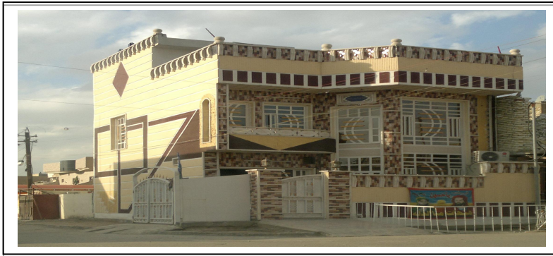
صورة (2): وحدة سكنية مشيدة ثلاثة طوابق
