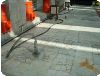
اللوحة 7 خرطوم الحقن اثناء عملية الحقن لاحد ابار الجناح الغربي داخل الصحن الشريف
