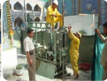
اللوحة 5 اعمال الحفر لآبار الحقن داخل الصحن الشريف قرب باب الامام موسى الكاظم (ع)
