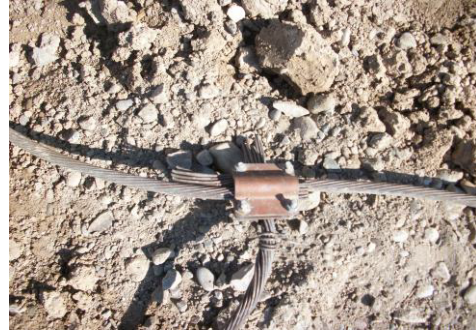
الشكل ( 13 ) توصيل أسلاك منظومة التأريض
