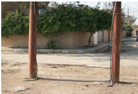
الشكل ( 18 ) توصيل سلكي التأريض الى القطبين
