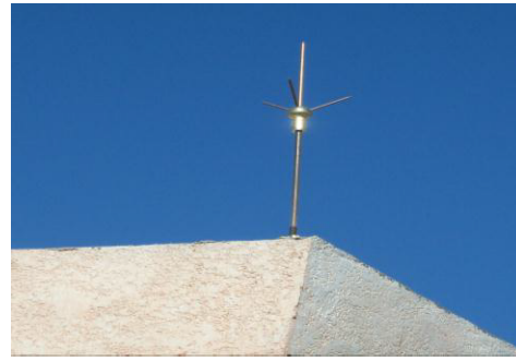
الشكل ( 15 ) مانعة الصواعق فوق بناية المحطة
