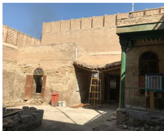
شكل (٩) الجناح الشمالي للمدرسة يتوسطه ايوان المدخل
