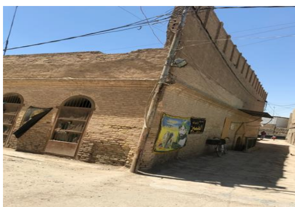
شكل (٢) واجهة المدرسة
