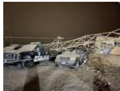
صورة (4) سقوط الاعمدة الكهربائية على السيارات بسبب العواصف الغبارية
