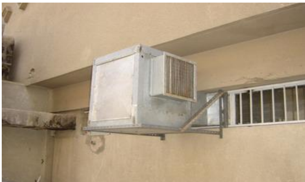
صورة (4) : تبين كيفية إطلاق أبخرة المذيبات المستعملة في تحضير الخلطات الصيدلانية لإنتاج الحبوب والمعلقات حيث يتم تجفيفها بالحرارة في معدات تجفيف مخصصة وتسحب هذه الأبخرة عبر ساحة الهواء الجوي .
