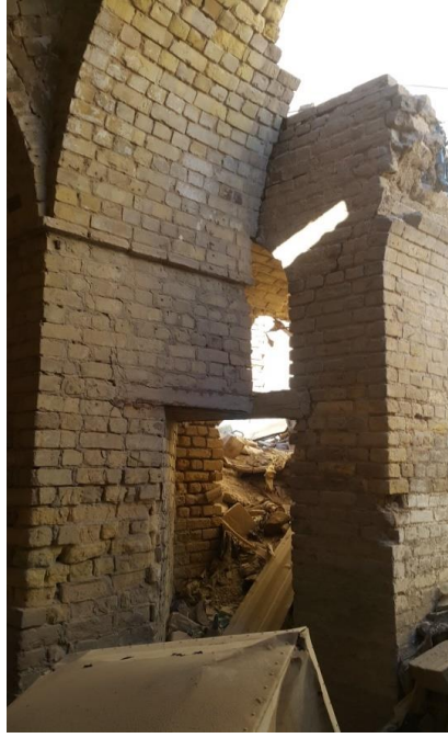
(شكل - ٢) المداخل المنكسرة في القاعة الاولى
