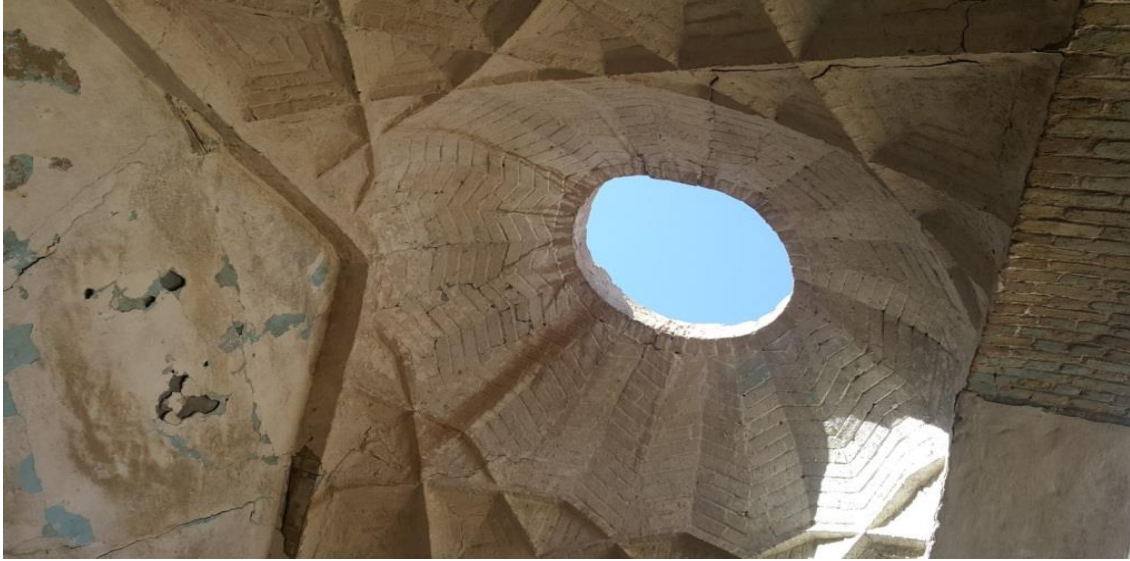
(شكل - ١١) القبة المضلعة التي تعلو القاعة الثالثة
