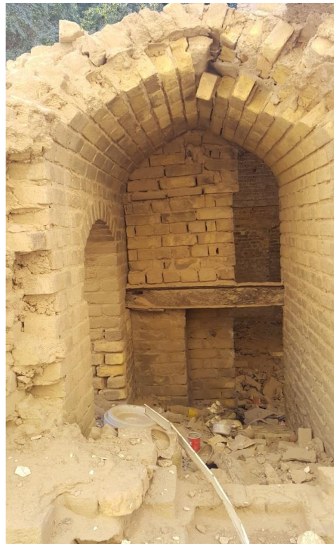
( شكل - ١ ) القبو المدبب الذي يسقف مدخلي القاعة الاولى
