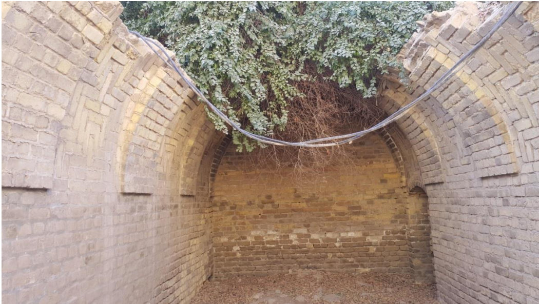
(شكل - ٧ ) فتحات التهوية والاضاءة للحجرات الملحقة بالقاعة الاولى
