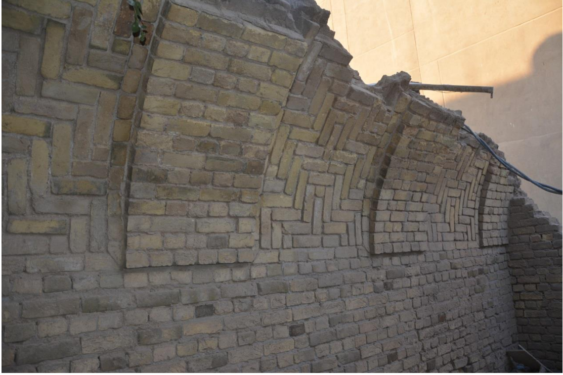
(شكل - ٩ ) طريقة التلاعب بصفوف الاجر في جداران القاعة الثانية لتشكيل حلية هندسية
