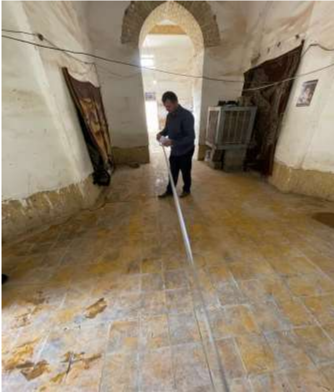
ملحق رقم (١٥) المدخل الشمالي الثانوي الذي يؤدي الى القاعة المثمنة (تصوير الباحث)
