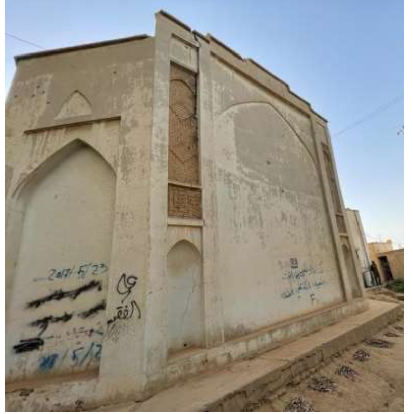
ملحق رقم (٩) الواجهة الشرقية للمتحف (تصوير الباحث)
