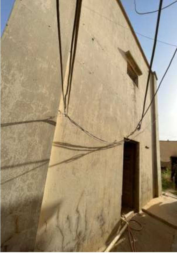
ملحق رقم (١٣) واجهة المتحف الشمالية ومدخلها (تصوير الباحث)
