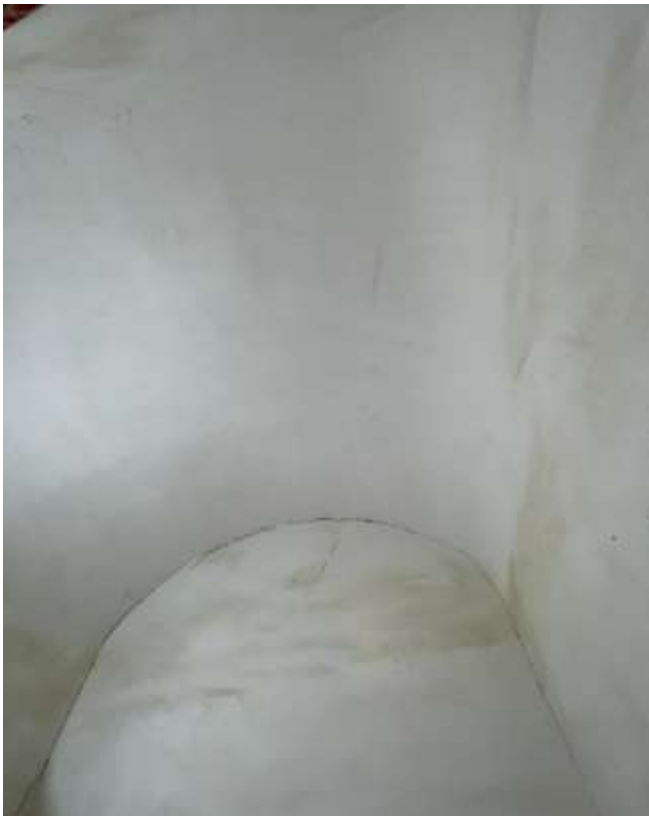
ملحق رقم (٢٣) احد سقوف الاقبية النصف اسطوانية لمبنى المتحف (تصوير الباحث)
