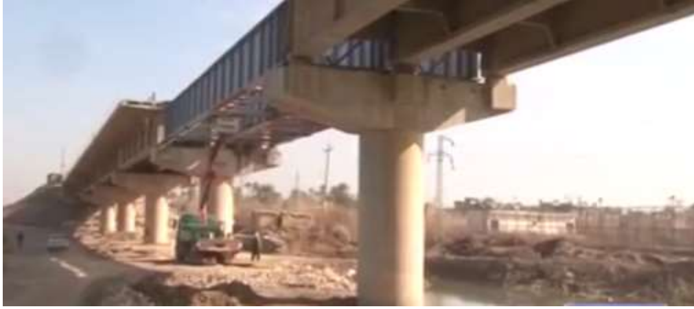
صورة (10) اثناء اعمال اعمار جسر الضلوعية الكونكريتي
